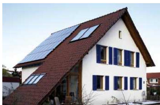
Solarni kolektori i fotonaponski paneli
